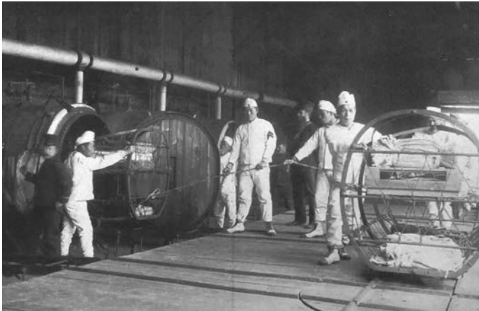
水蒸気消毒汽缶を用いた消毒作業
